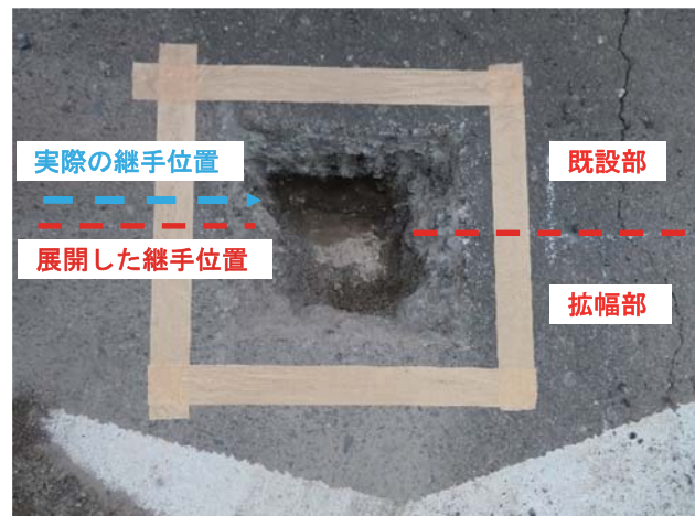
写真-11 舗装厚調査状況
