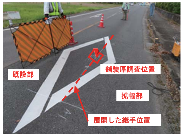
写真-10 舗装厚調査位置特定状況
