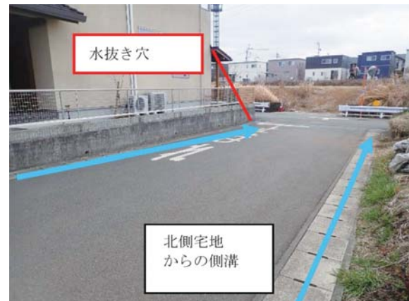
写真-4 宅地水抜き穴
