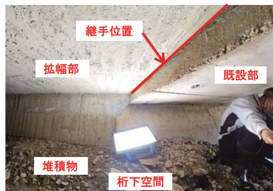
写真-3 既設部と拡幅部の継手位置
