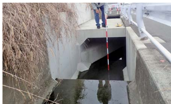
写真-6 落差工及びボックスカルバート (上流側より望む)
