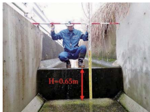
写真-5 落差工(下流側より望む)
