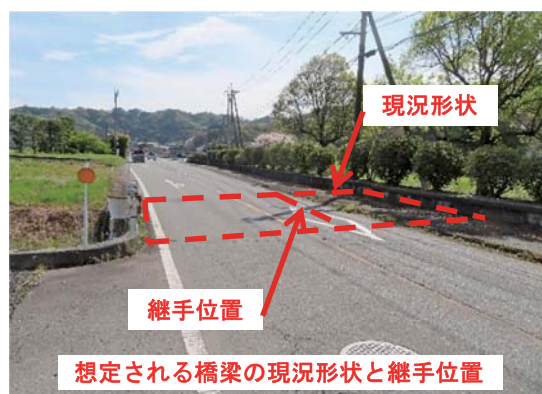
写真-1 オーバーレイ舗装された橋面
