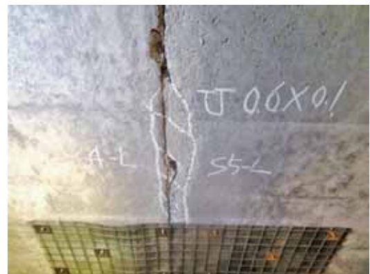
写真-5 横断目地部のうき(近景)
