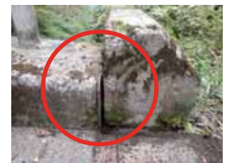
写真-5 地覆部の状況 (止水材無)
