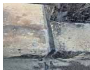
写真-8 地覆部の補修
