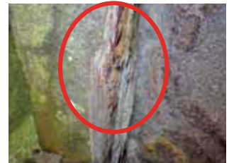
写真-3 補剛材の断面減少
