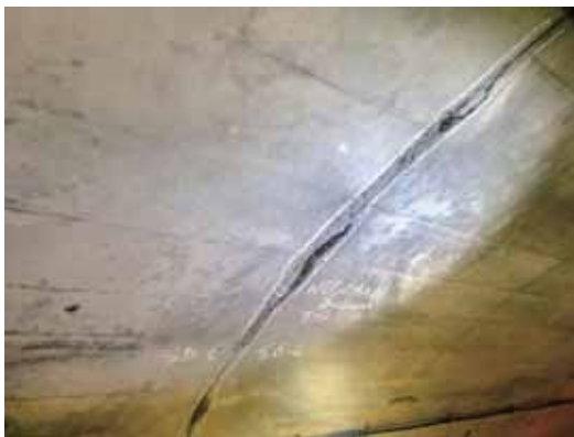
写真-4 横断目地部のうき(全景)
