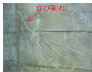
写真-2 主構のひび割れ
