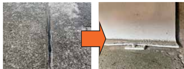
写真-6 伸縮装置 ゴム部分のみ補修
