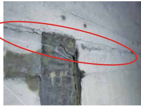
写真-3 水平打ち継ぎ目部のうき
