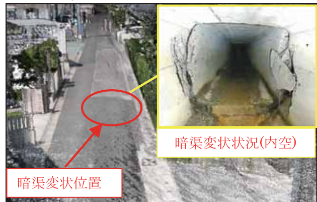
図-3 暗渠構造物の変状位置と地上位置
