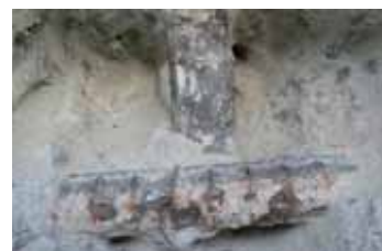
写真-4 P1橋脚下部はつり調査
