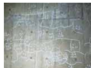
写真-3 橋脚のひび割れ
