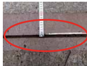
写真-4 伸縮装置の状況 (止水性低下)
