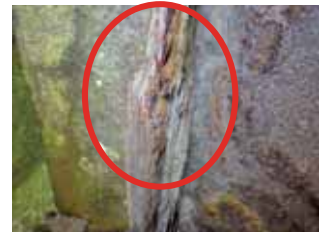
写真-3 補剛材の断面減少
