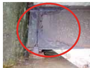
写真-2 桁端部安定錆が形成されていない
