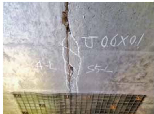
写真-5 横断目地部のうき(近景)
