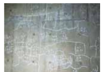
写真-3 橋脚のひび割れ
