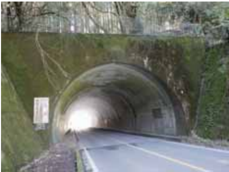
写真-1 二瀬本隧道
