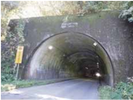
写真-2 笹尾トンネル
