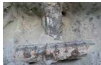
写真-4 P1橋脚下部はつり調査
