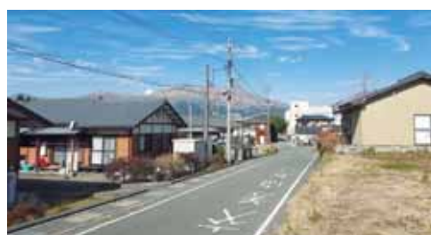
写真-1 無電柱化計画路線の現況写真
