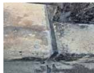
写真-8 地覆部の補修
