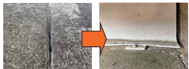
写真-6 伸縮装置 ゴム部分のみ補修
