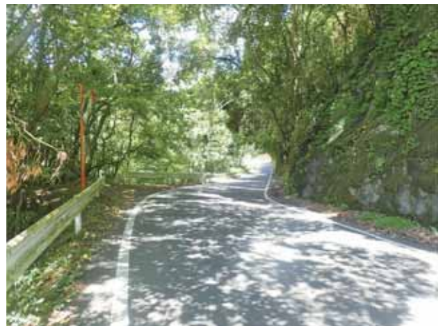
写真-2 現地状況写真 (カーブが続く道路状況)
