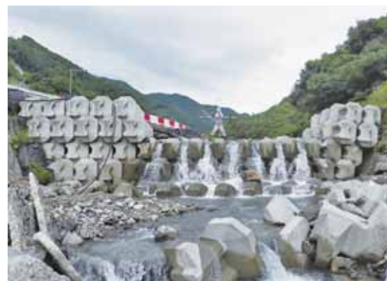
写真-4 仮設床固工設置状況
