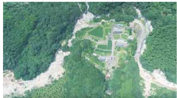
写真-2 調査地災害状況(広域)
