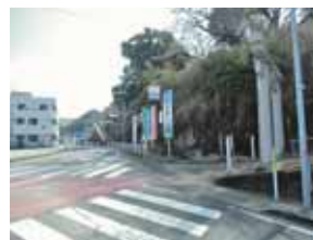
写真-3 ブルーシート設置前
