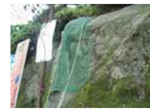
写真-6 応急対策後状況
