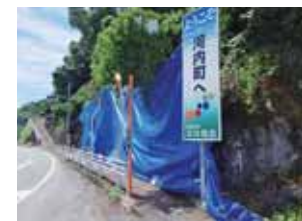
写真-4 ブルーシート設置後
