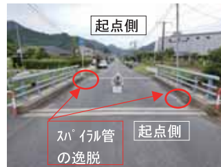
写真-6 C橋 橋面
