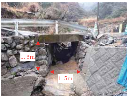
写真-3 橋梁断面状況
