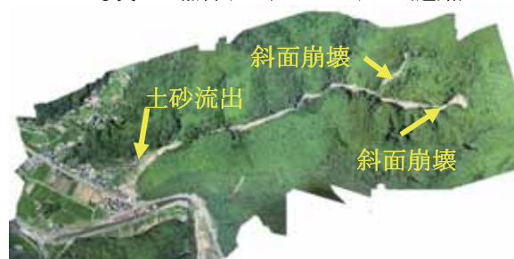
写真-10 土砂災害現場写真
