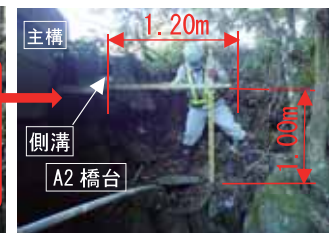
写真-5 A2橋台上流側
