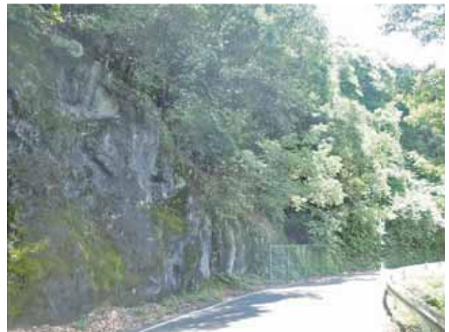
写真-1 現地状況写真 (切り立った斜面状況)
