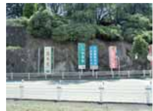
写真-2 伐採後法面状況
