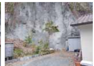
写真-10 法面下状況
