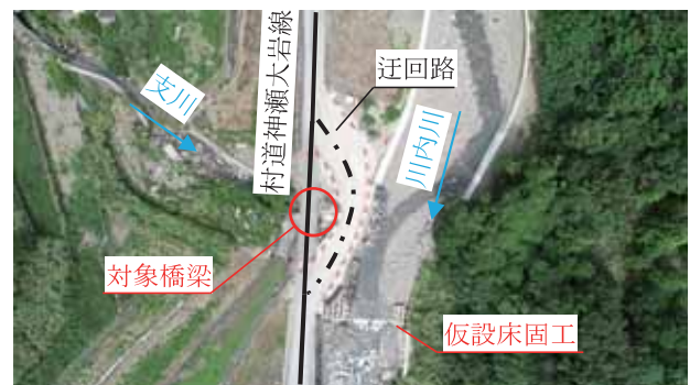
写真-1 現地航空写真
