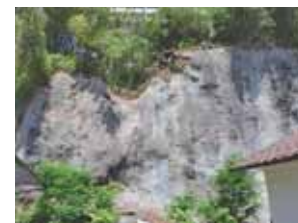
写真-9 法面上部状況
