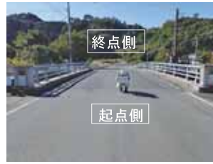
写真-1 A橋 橋面
