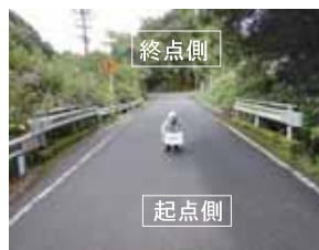
写真-3 B橋 橋面
