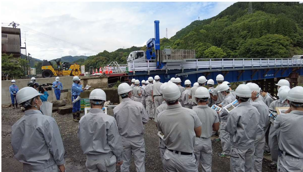
球磨川復旧工事
