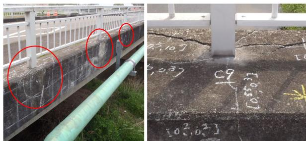
写真-1 外観上の地覆損傷状況
